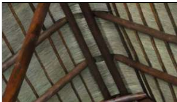
Neat finish to spreij layer
